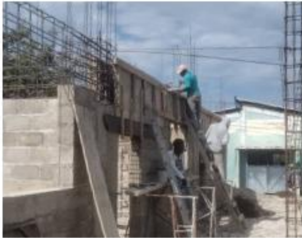
Bouw van de klaslokalen.
